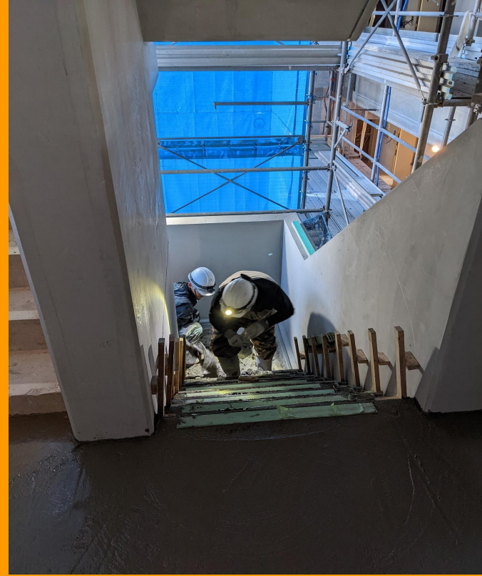
階段床モルタル塗り
